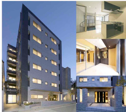
東京都豊島区 R C造地上5階地下1階 859m 2
